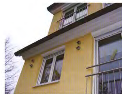
Eine Fassade mit 10 cm starker Wärmedämmung und neue Fenster mit Dreifachverglasung sorgen in Kombination mit der Komfort-Lüftungsanlage von Meltem für eine gute Energiebilanz.
