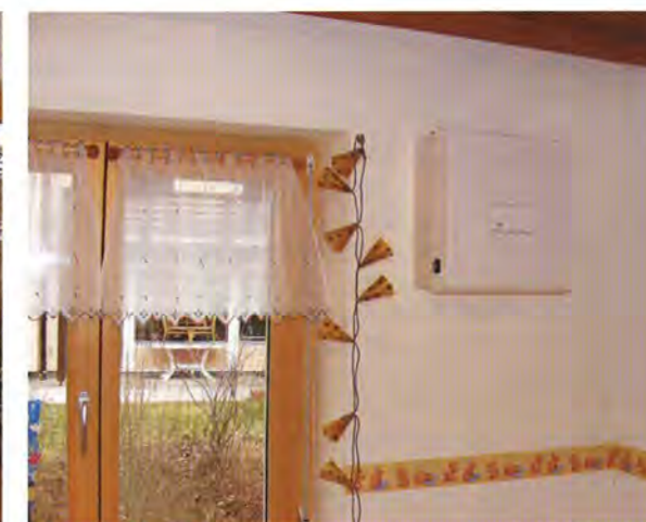
In den Wohn-, Kinder- und Schlafzimmern wurden die Lüftungsgeräte an den Außenwänden installiert.
