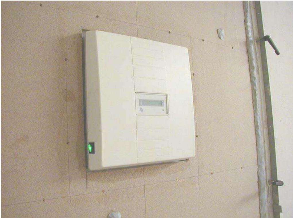
**Ansicht der Trockenbaukonstruktion mit Lüftungsgerät M-WGR-S / K UP
