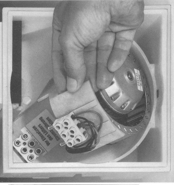
**3.** Lüfterteil am Lüftenträger mit Daumen und Zeigefinger, wie auf Bild (oben) gezeigt, anfassen und gemäß Bild (rechts) einsetzen. Hierbei rastet der Stecker automatisch in das Elektroanschlußteil ein.
