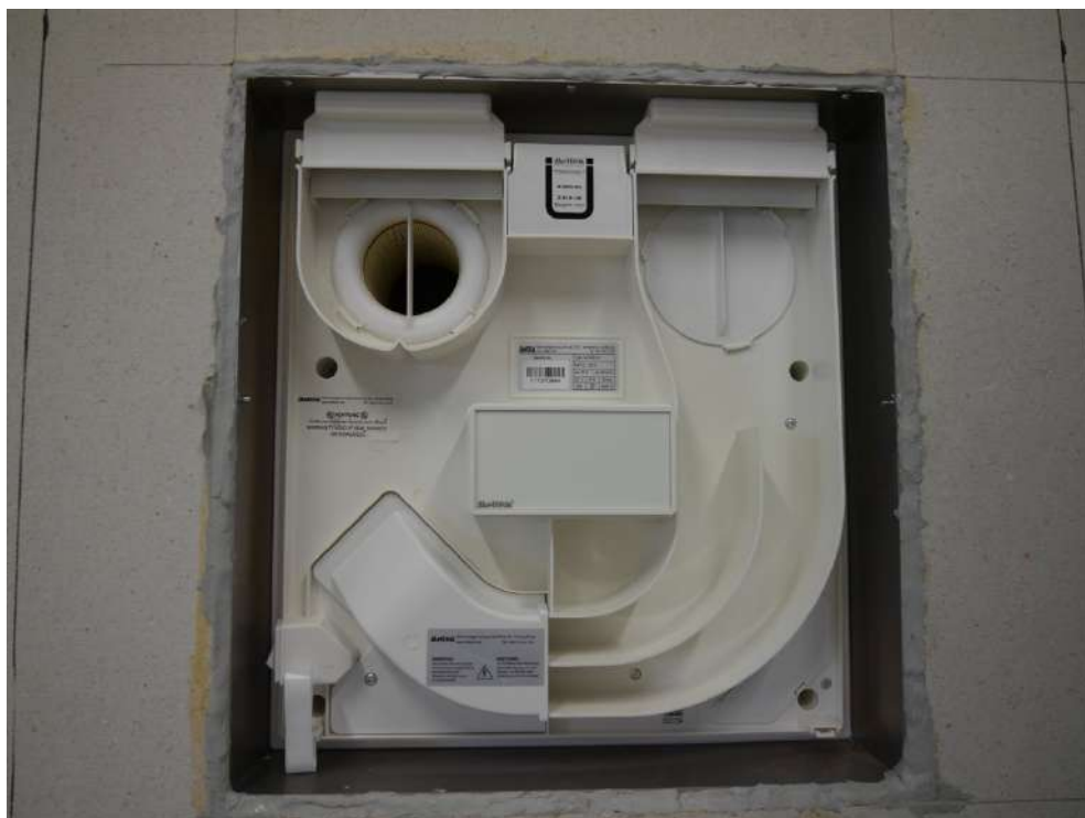
Abbildung C.10. Ansicht Lüftungsgerät innenseitig nach Montage der Vorsatzschale, Gerätedeckel entfernt.
