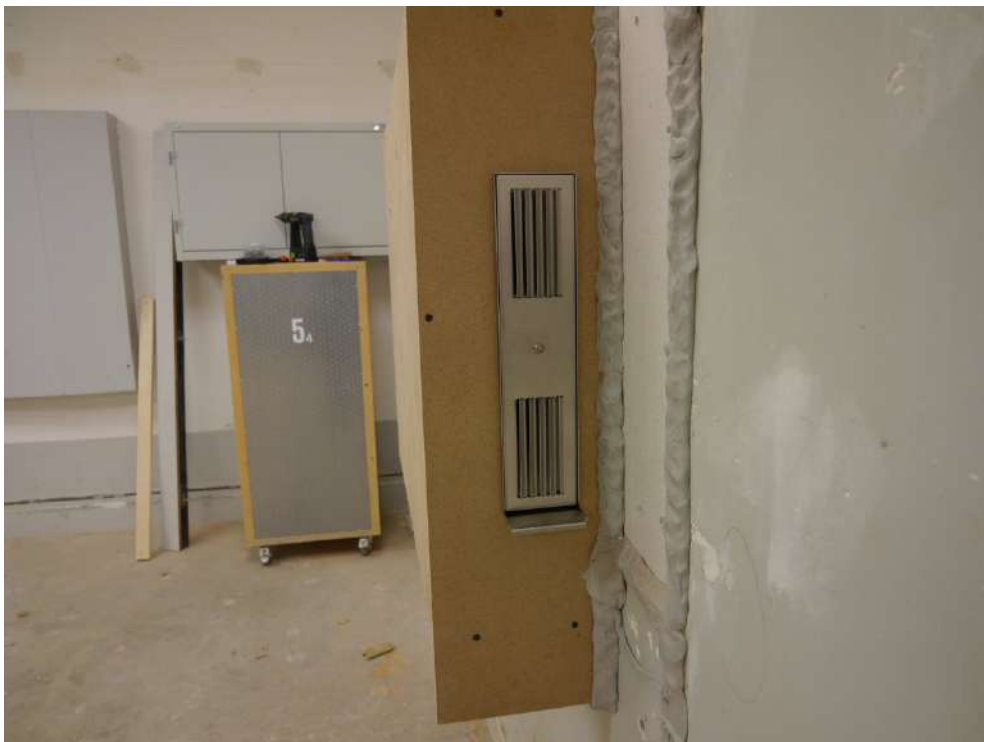
Abbildung C.6. Variante Fensterlaibungslösung: Detailansicht des montierten Fassadenabschlusses auf der nachgebildeten Fensterlaibung.
