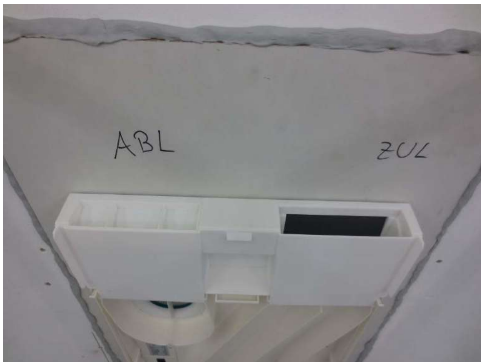
Abbildung E.12. Mehr-Raum-Variante während der Montage: Lüftungsgerät geöffnet, und Kanaladapter für Kanalanschluss aufgesetzt (hier: Variante mit Kanalanschluss ABL-seitig).
