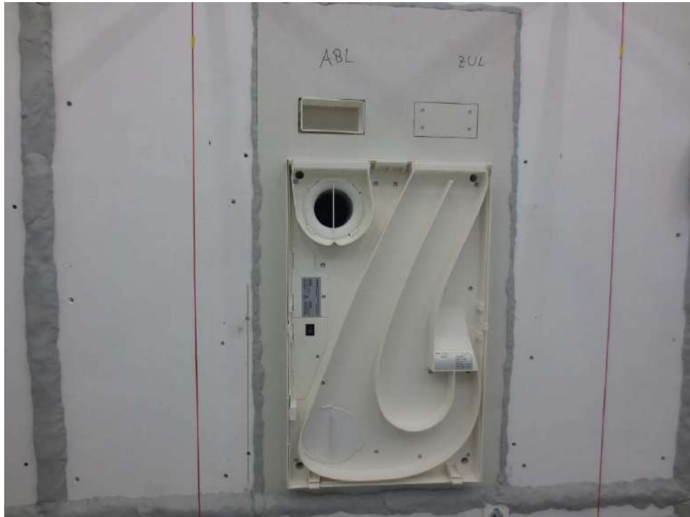
Abbildung E.11. Mehr-Raum-Variante während der Montage: Lüftungsgerät geöffnet, Kanalanschluss durch Trockenbaublende geführt (hier: Variante mit Kanalanschluss ABL-seitig).
