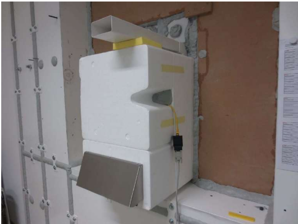
Abbildung D.6. Prüfvariante mit Kanalanschluss ABL-seitig: Schrägansicht Außen-seite (prüffertig). Kanalanschluss ABL nach außen (Senderraum) geführt.
