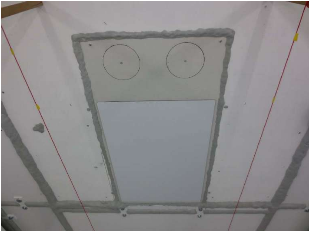
Abbildung D.14. Prüfvariante mit Kanalanschluss ABL- und ZUL-seitig: Ansicht Innenseite oben (prüffertig).
