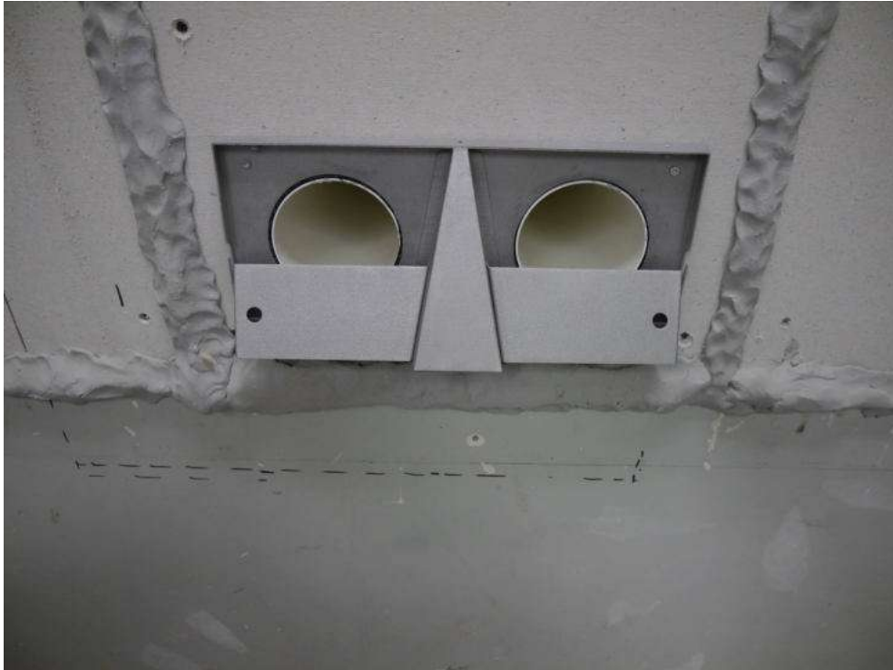
Abbildung B.5. Lüftungsöffnungen außenseitig mit teilweise montiertem Fassadenabschluss (Wandhalterung der Edelstahlschote).
