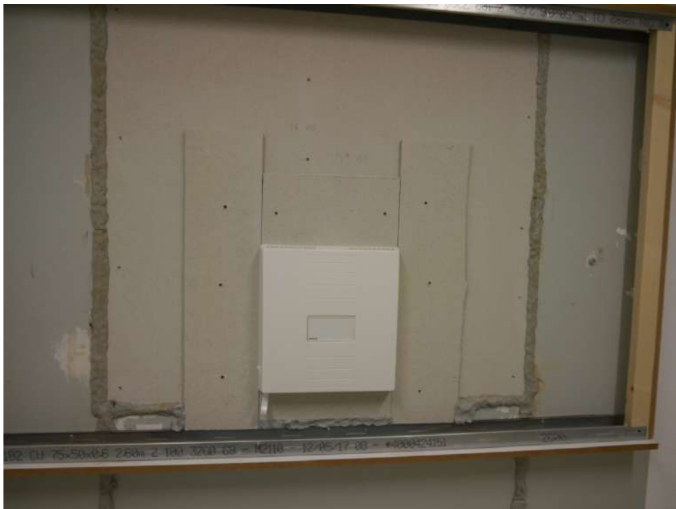
Abbildung B.16. Einbauvariante M-WRG-M (-MB) UP-Standard: Raumseitige Ansicht Lüftungsgerät mit Gerätedeckel (prüffertig).
