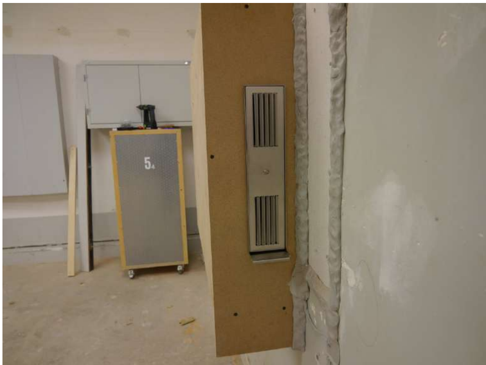
Abbildung B.4. Außenseitige Detailansicht Fassadenabschluss Fensterlaibung auf der nachgebildeten Fensterlaibung montiert.
