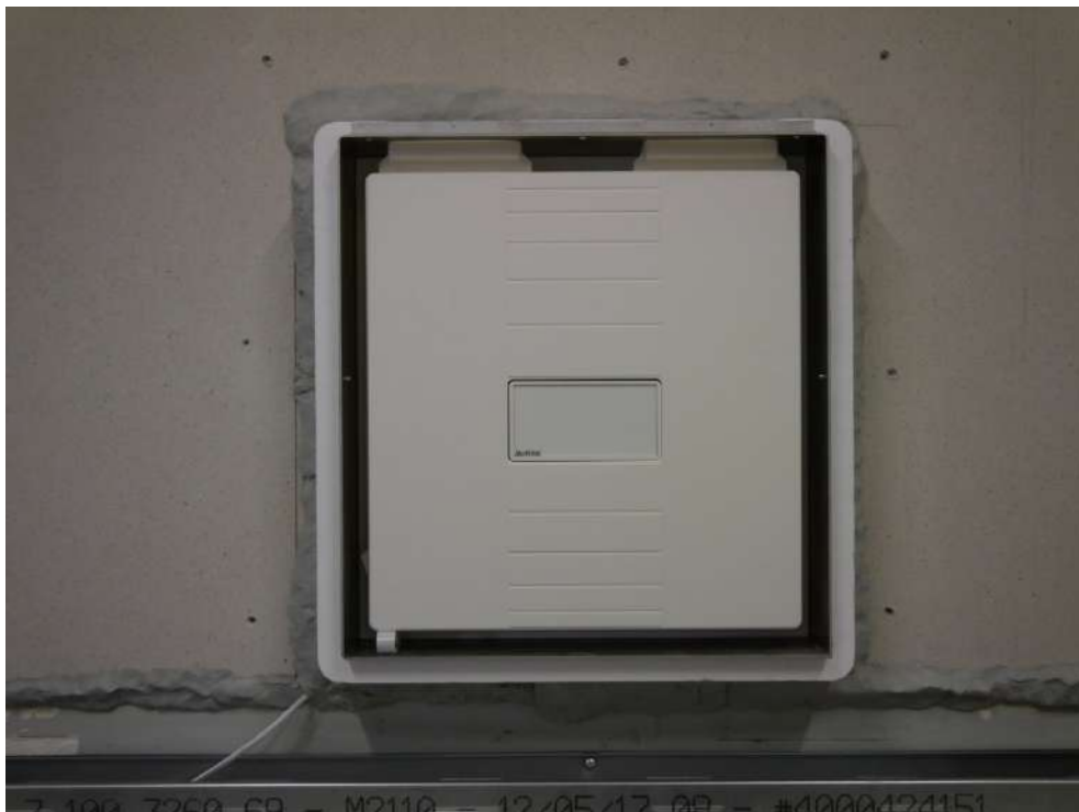
Abbildung B.6. Einbauvariante U 2 : Raumseitige Ansicht Lüftungsgerät vor Montage der Vorsatzschale, Abdichtung zum Prüfstand vollständig.
