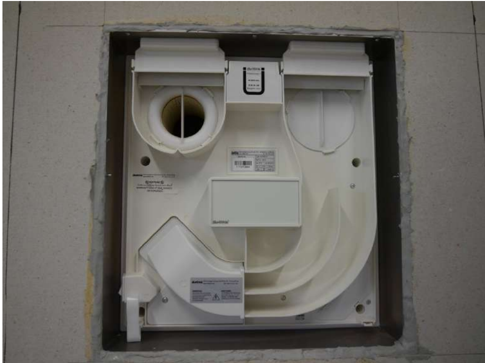
Abbildung B.9. Einbauvariante U 2 : Raumseitige Ansicht Lüftungsgerät nach Montage der Vorsatzschale, Gerätedeckel entfernt.
