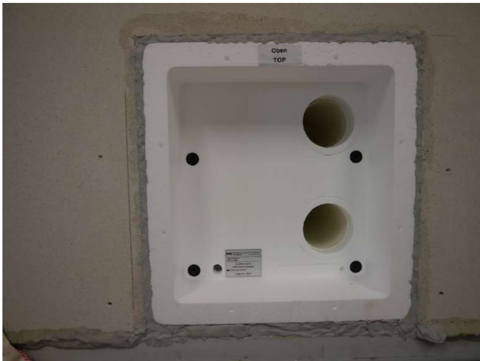
Abbildung B.14. Raumseitige Ansicht, Montageset UP in Wandöffnung eingesetzt und abgedichtet.
